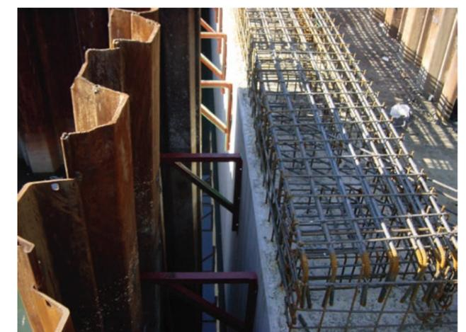
適用例：河川架橋工事において、仮設足場用ブラケットに使用された例です。使用時の腐食の恐れがないだけでなく、使用後に行われるかぶり確保のための金属性アンカーの撤去(一部切断)・モルタル充てんなど、面倒な処置が不要です。
